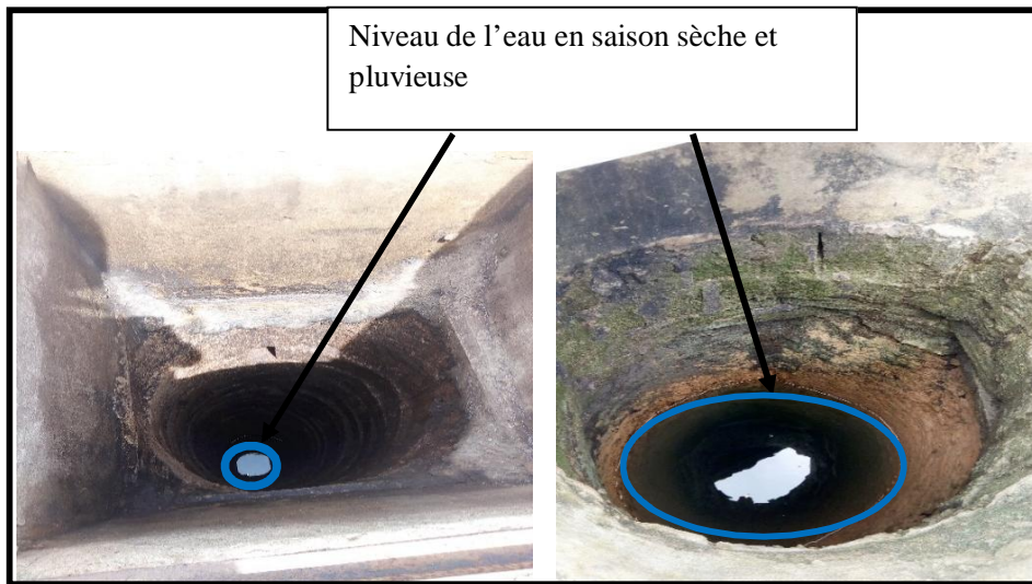
Planche 1 : l'état d'un puits en saison sèche (à gauche) et saison pluvieuse (à droite) à Attékro (Didievi)
